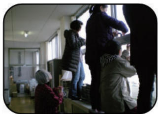
空振対策テープ張り
